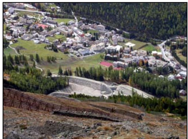
Abb. 5: Rückhaltedamm bei Pontresina zum Schutz vor Lawinen und Murgängen aus einem Anrissgebiet mit schwindendem Permafrost. Der Schutzdamm wurde 2003 fertiggestellt. Im Vordergrund Stützverbau gegen Lawinen im offenen Steilhang (Foto: M. Maisch, 2005).
